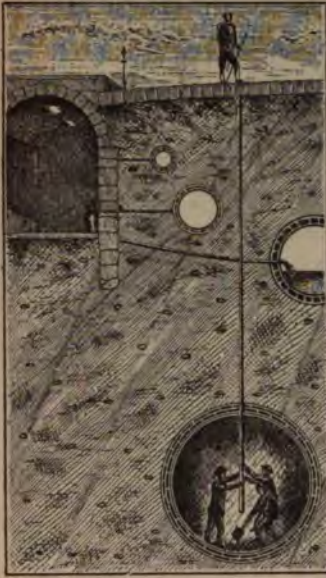
Fig. 53. — Vérification de l'alignement, système Beach.
